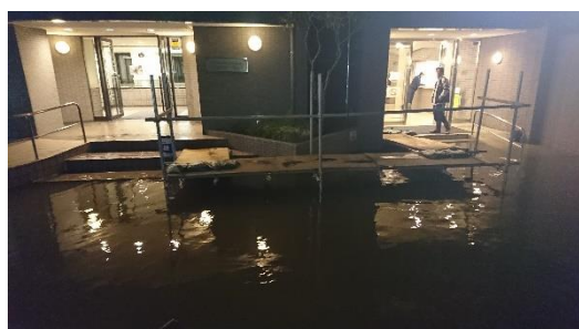
2017年10月、台風 21号での 赤堀川溢水による敷地内の冠水
