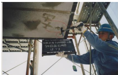
第1回大規模修繕工事 ベランダ軒下補修
