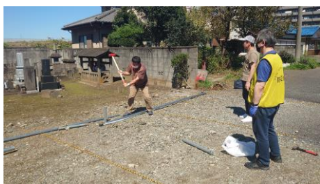
単管パイプで車止め作製
