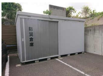
第6駐車場内の 防災倉庫
